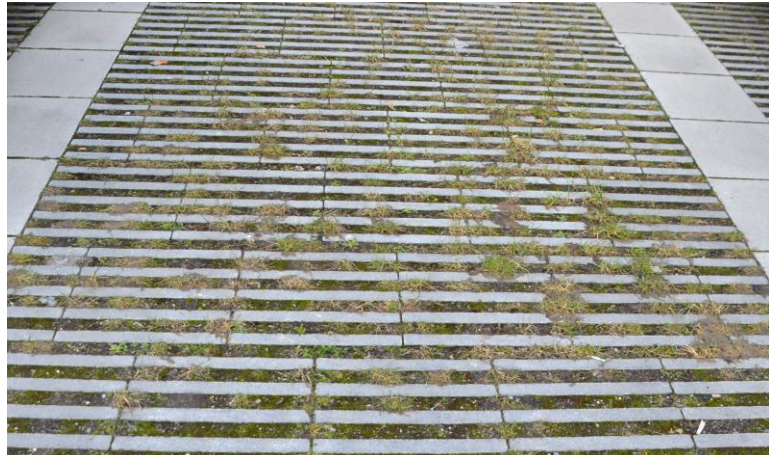
„Rasenliner“, Stellplätze entlang der Straße „An der Rems“
