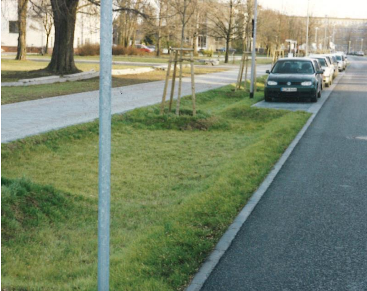
Muldenversickerung in Berlin Adlersdorf, [Quelle: Bluegreenstreets Toolbos Teil A]
