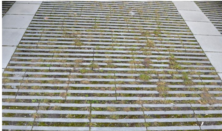
„Rasenliner“, Stellplätze entlang der Straße „An der Rems“
