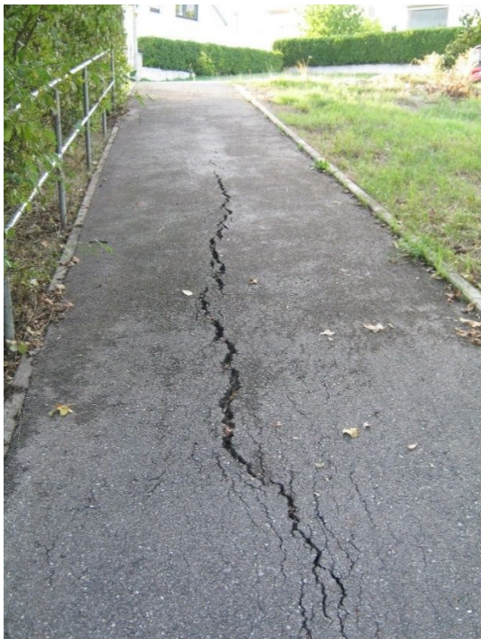
Abb. 3: Fußweg ca. 200 m südöstlich des Grundstücks zwischen der Südost-Ecke der Johann-Ludwig-Huber-Straße und dem benachbarten, zu den Weinbergen führenden Fahrweg (Aufnahme eines Anwohners)
