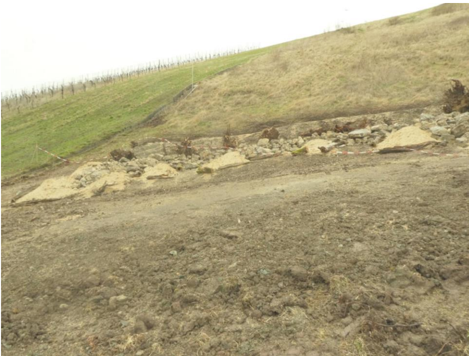
Abbildung 5: Angesäte Rohbodenfläche (im Vordergrund), neu angelegte Habitatflächen (im Mittelgrund) und Altgrasbereiche (im Hintergrund) nach Umsetzung der Maßnahme
