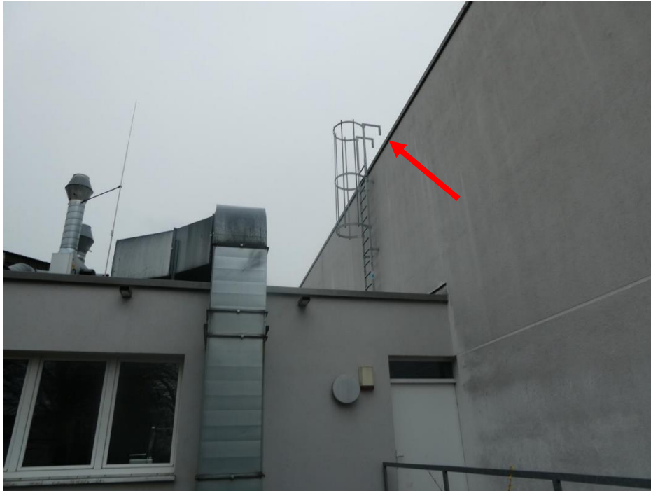
Abbildung 8: Prinz-Eugen-Halle mit geeignetem Standort für das Anbringen eines Turmfalkenkastens
