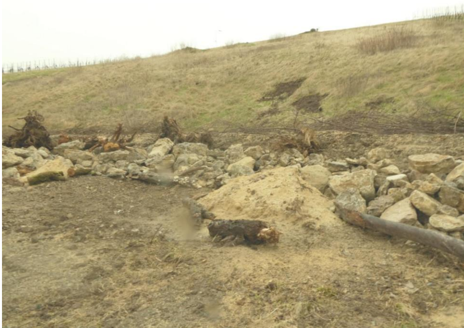
Abbildung 7: Sandlinsen, Steinhaufen, Holzstämme am Unterhang der FCS Fläche nach Umsetzung der Maßnahme
