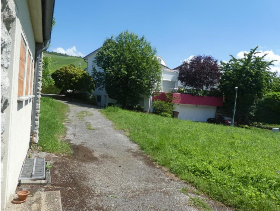
Abbildung 6: Versorgungsgebäude und Grünland, Blick nach Osten
