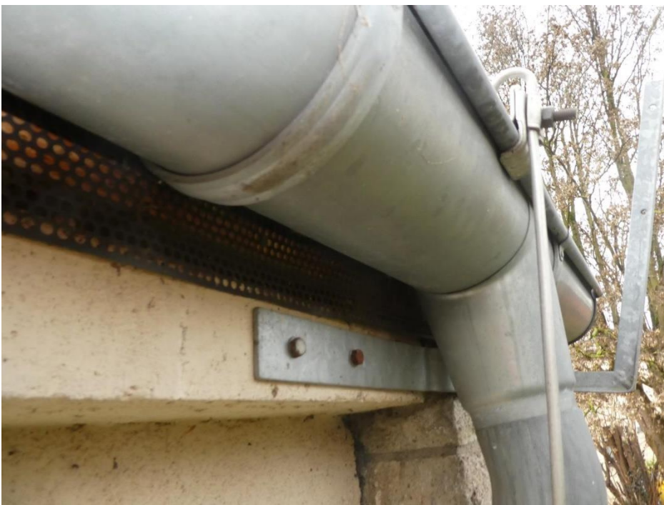
Abbildung 7: Versorgungsgebäude mit sog. Vogelschutzblech
