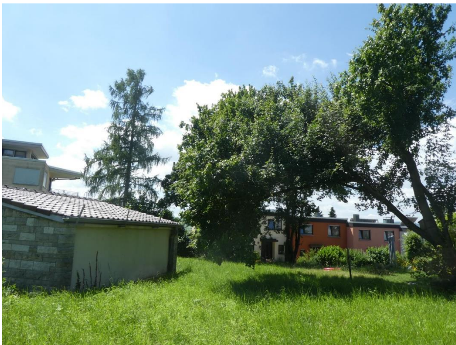
Abbildung 5: Versorgungsgebäude und Grünland
