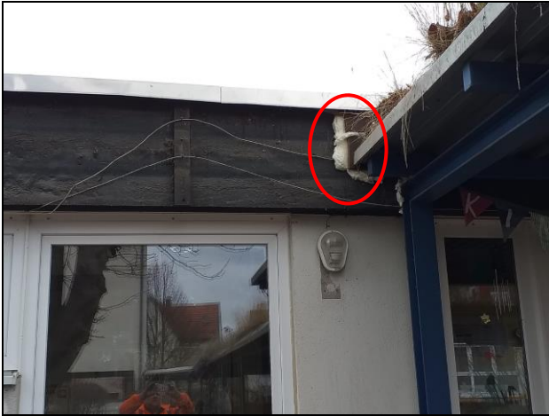
Abgebaute Holzverkleidung und mit Bauschaum verschlossene Spalten
