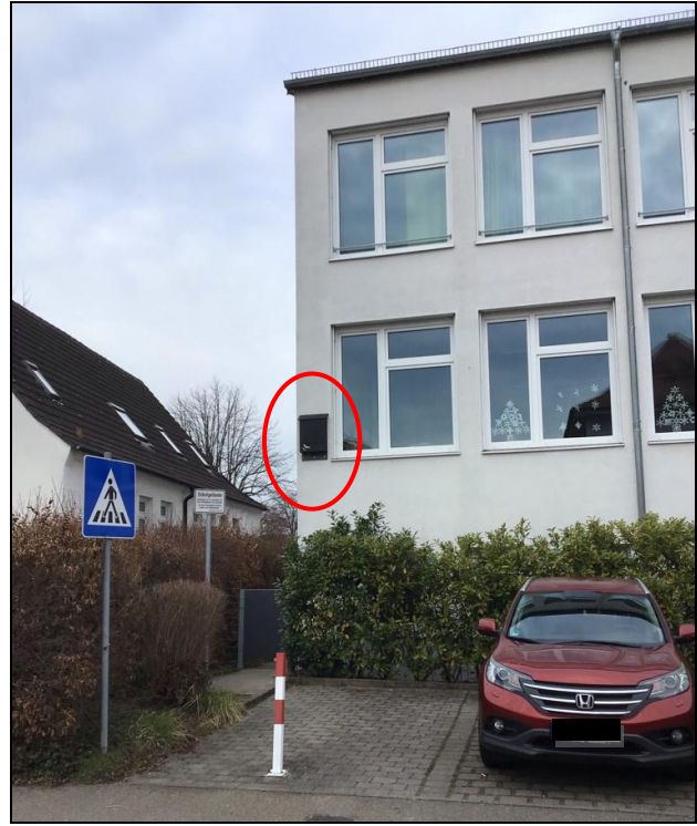
Fledermausflachkasten Typ „VK MP 06“ an südöstlicher Ecke des Schulgebäudes
