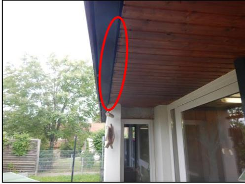
Spalten zwischen Fassade und Dachverkleidung bei Abbruchgebäude 2
