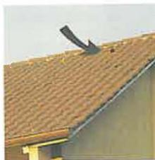
3. Lüftungsziegel als Einflugmöglichkeit, jedoch nur auf einer Seite des Hauses, um Durchzug zu vermeiden (Sieb heraustrennen). Unterspannfolie an diesen
