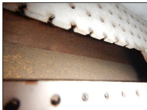
Holzverkleidung unmittelbar hinter Lüftungsschlitzen bei Abbruchgebäude 1
