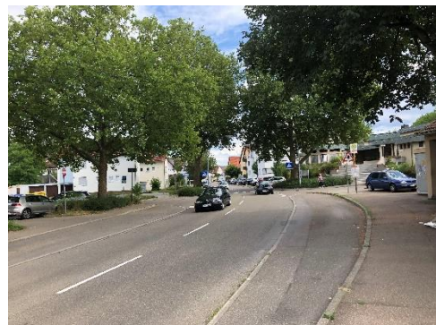
Überdimensionierte Fahrbahn/ nicht barrierefrei Busbuchten an der Ulrichstraße Quelle: BLU architekten
