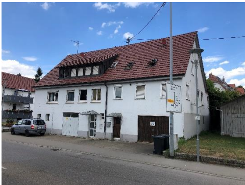
Erheblicher Mangel in der Bausubstanz Buhlstraße Quelle: BLU architekten
