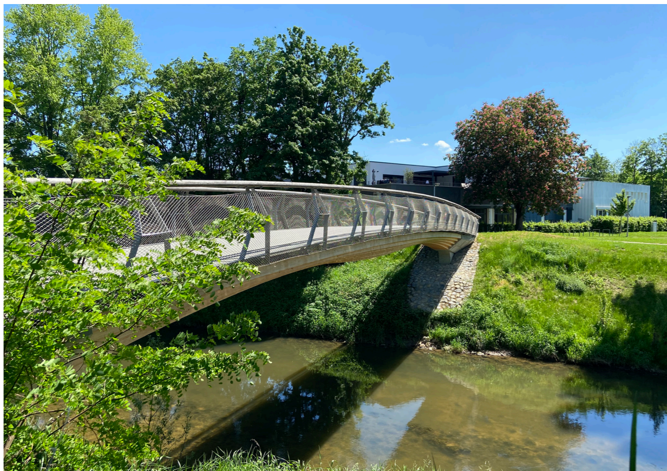
Neue Holzbrücke über die Rems
