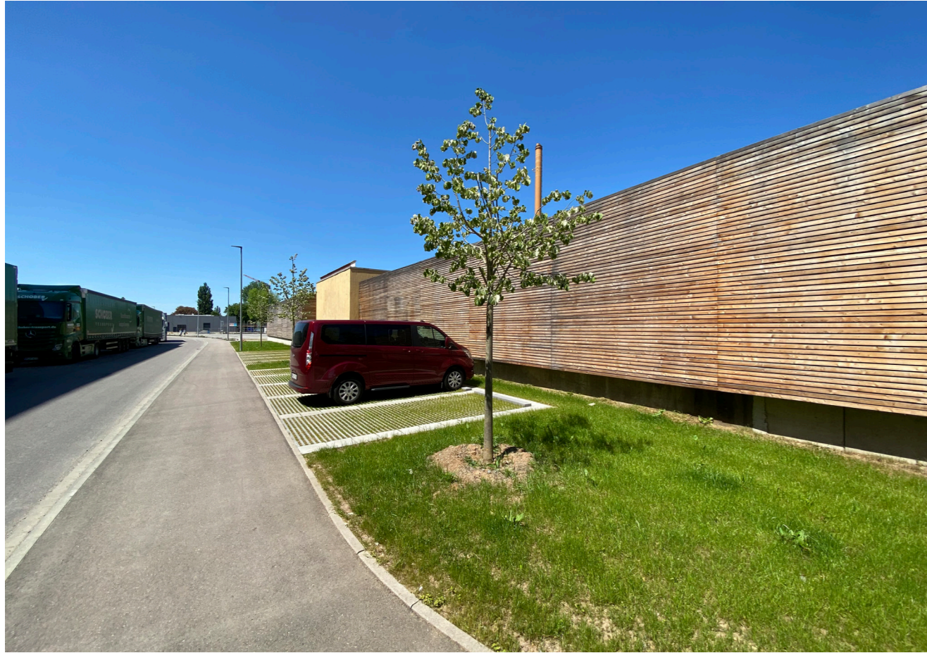
Zusätzliche öffentliche Stellplatzflächen entlang der Straße „An der Rems“
