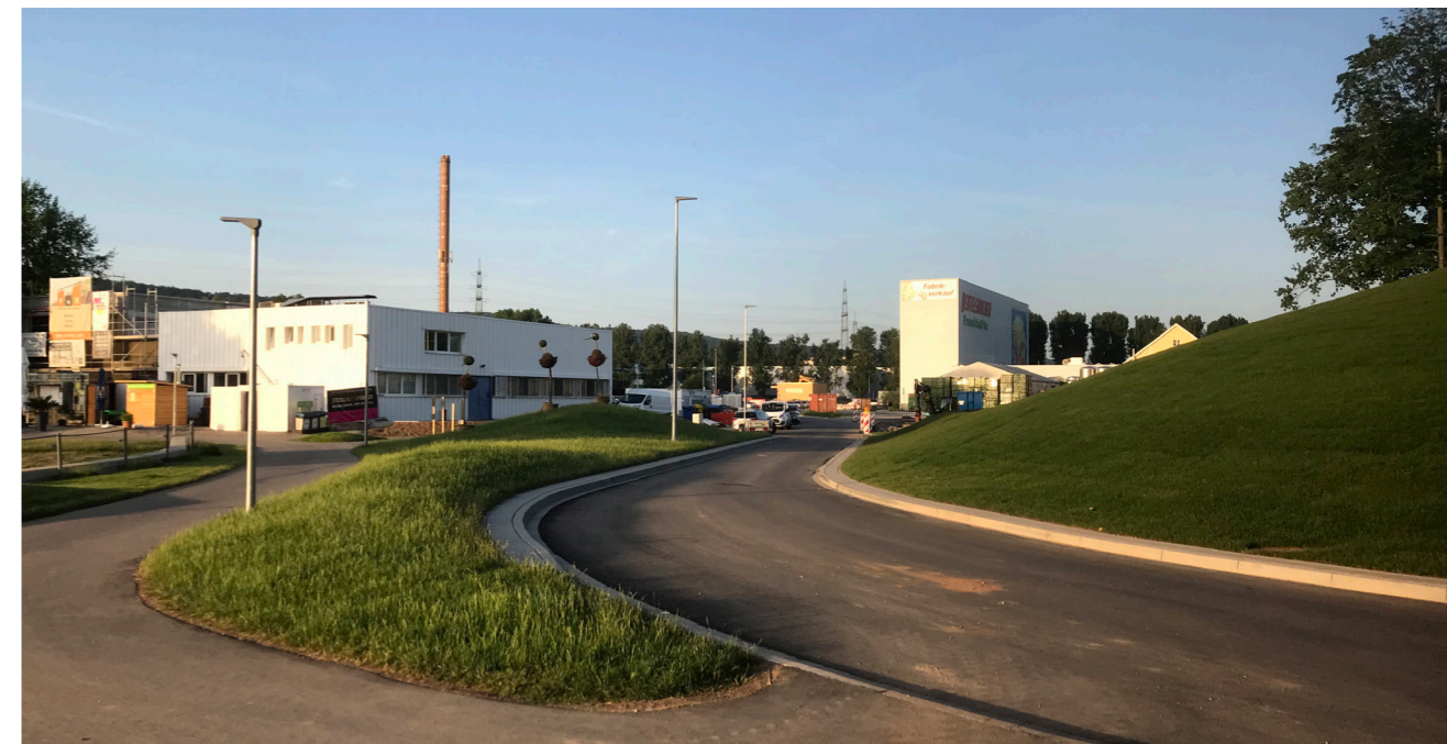
Neue Erschließungsstraße „An der Rems“
