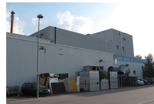
Birkelstraße 21 vor dem Abriss
