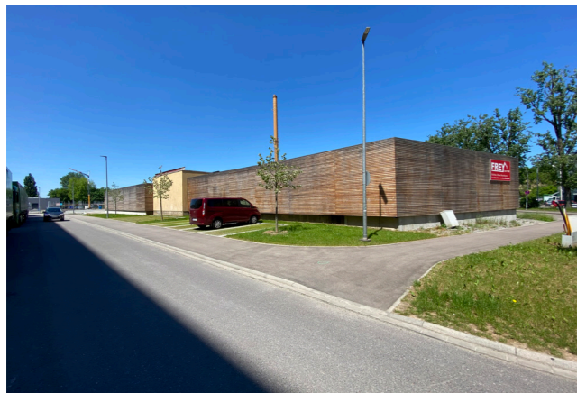
Straße „An der Rems“ mit neuer Lärmschutzwand
