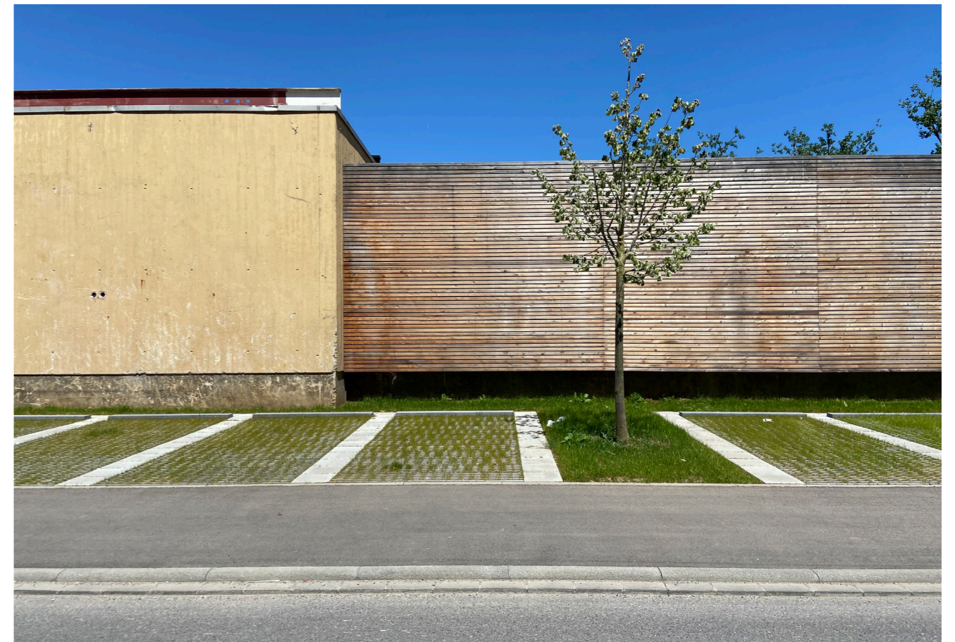
Neue öffentliche Stellplätze und neue Lärmschutzwand der Firma Frey
