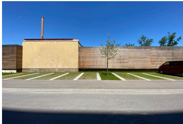
Neue Stellplätze vor der neuen Lärmschutzwand der Firma Frey
