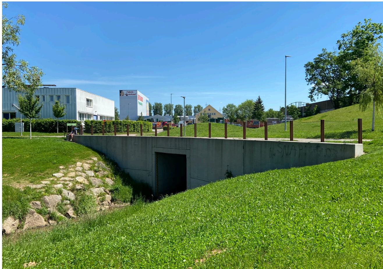
Verdolung des Haldenbachs zur Sicherstellung der Anschlussstraße
