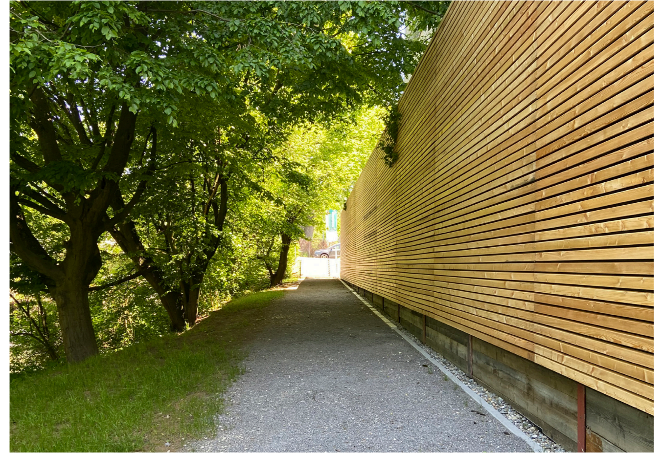
Neuer Fußweg entlang der Rems
