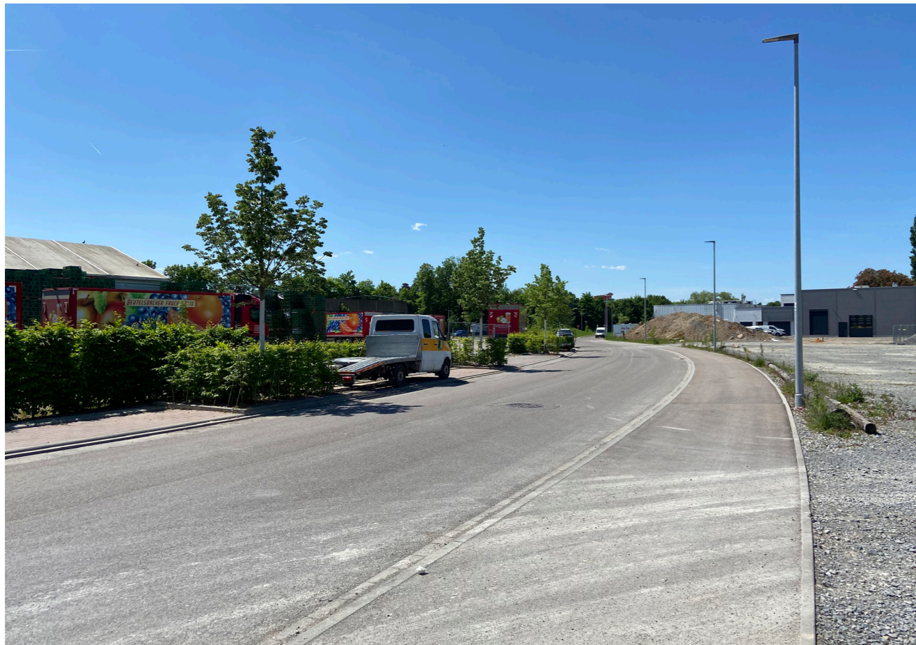
Neue Erschließungsstraße des Gewerbegebiets
