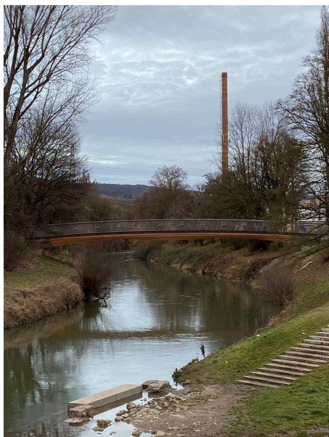
Neue Holzbrücke mit Birkelspitze
