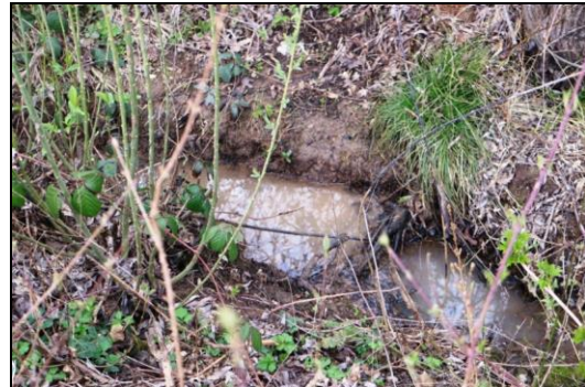
Wasseransammlung im Graben nördlich des asphaltierten Feldweges (außerhalb des Plangebiets)
