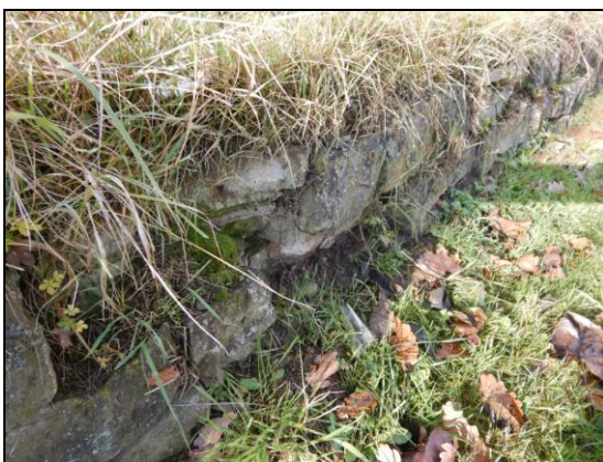
Detailansicht unverfugte Steinmauer am Ostrand
