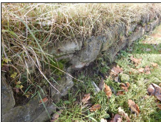
Detailansicht unverfugte Steinmauer am Ostrand
