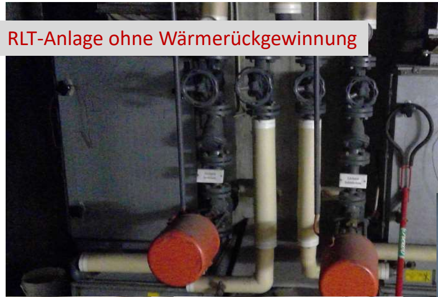
Überdimensionierte Heizverteilung rechnerische Lebensdauer überschritten
