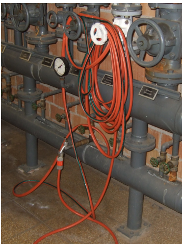
Schlauchanschluss
