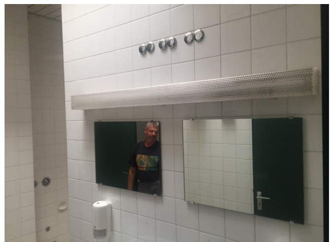
Leuchte freistrahlend im Duschaum und mit Wanne über Waschbecken
