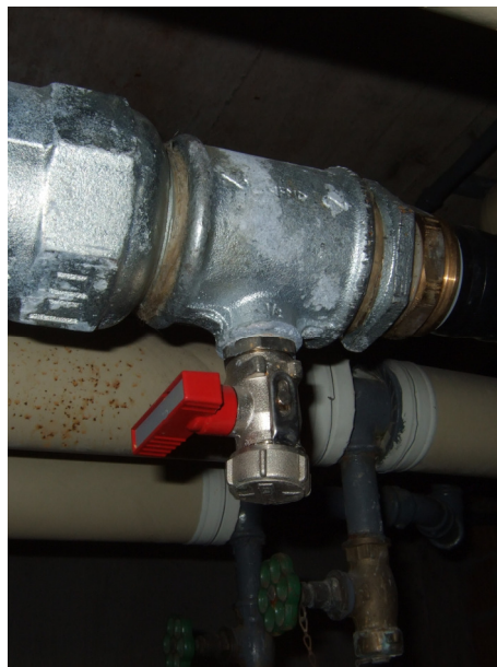
Bauteile ohne DVGW-Kennzeichnung
