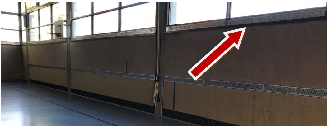
Zuluftnachströmung Hallenbereich
