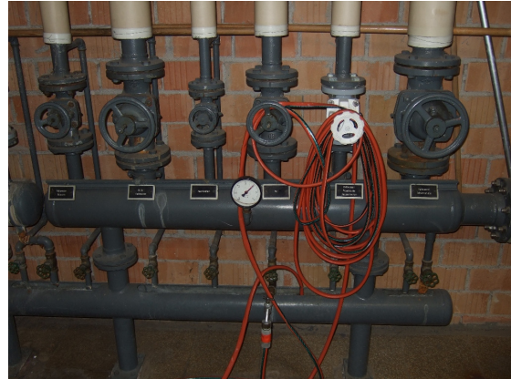
Kaltwasserverteiler
