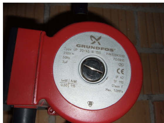
Zirkulationspumpe
