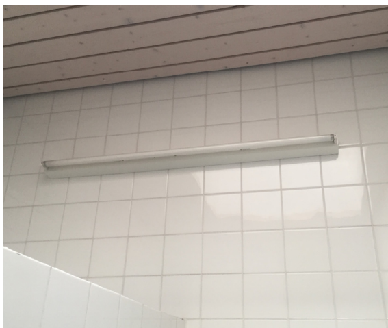
Leuchte freistrahlend im Duschaum und mit Wanne über Waschbecken
