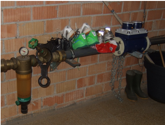
Hauswasseranschluss
