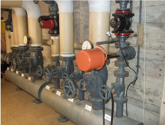
Heizungsverteiler
