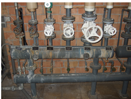
Verteiler Warmwasser und Zirkulation
