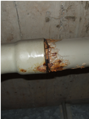
Korrosion
