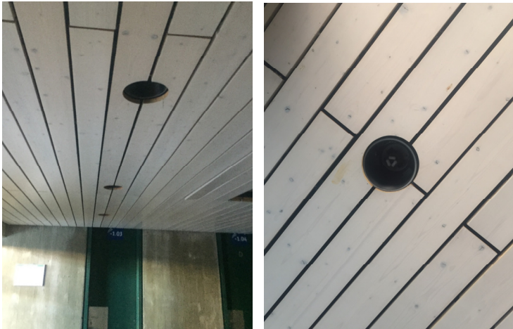
Einbaustrahler Flure
