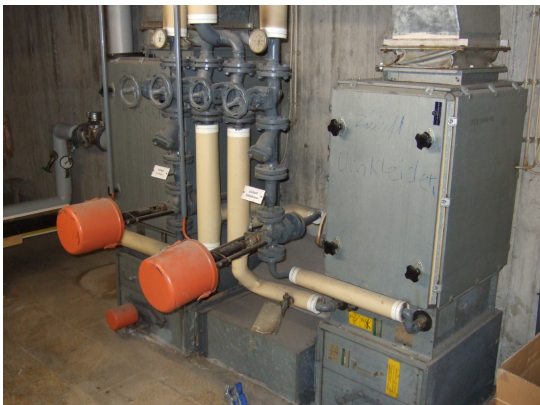
Zuluftgerät Duschräume/Umkleiden
