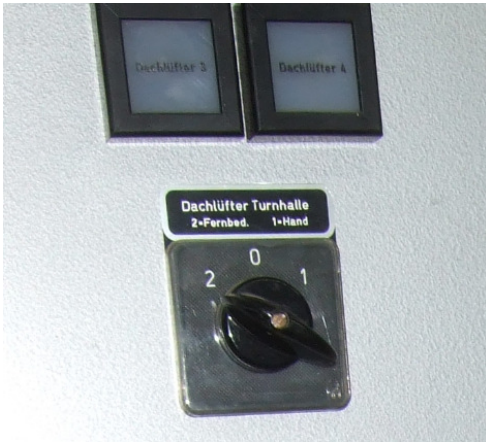
Bedienschalter Abluftventilatoren
