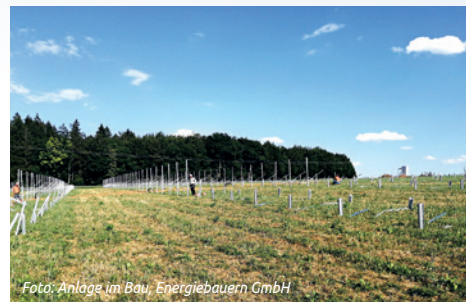
Foto: Anlage im Bau, Energiebauern GmbH
