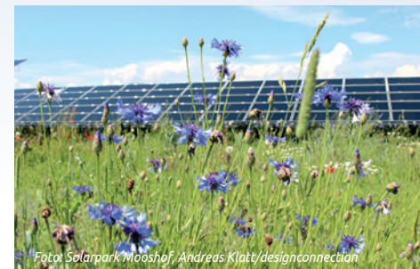
Foto: Solarpark Mooshof, Andreas Klatt/designconnection
