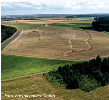
Foto: Energiebauern GmbH
