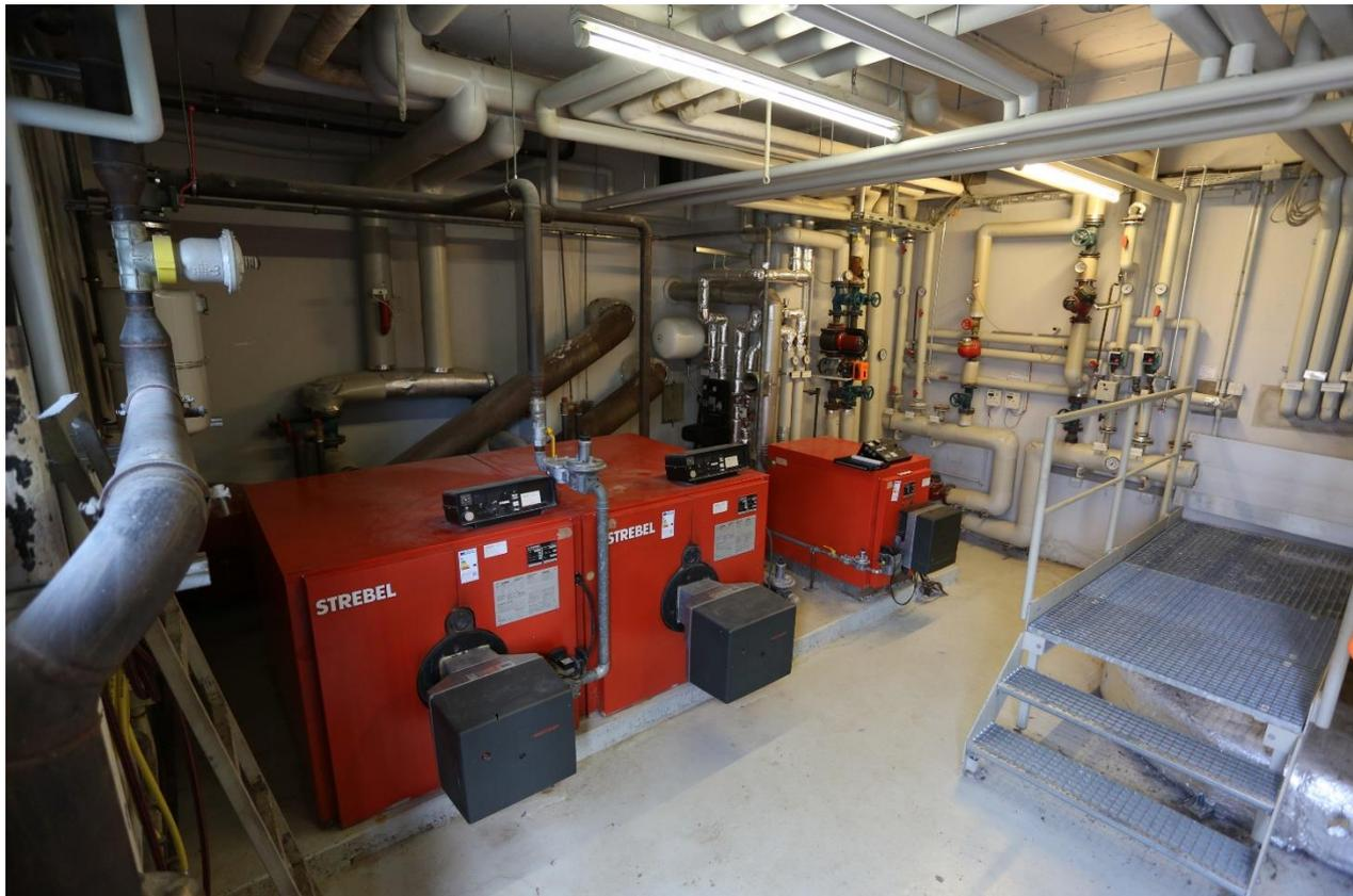
2 Heizkessel 262 kW Baujahr 1990 – 1 Kessel redundant
