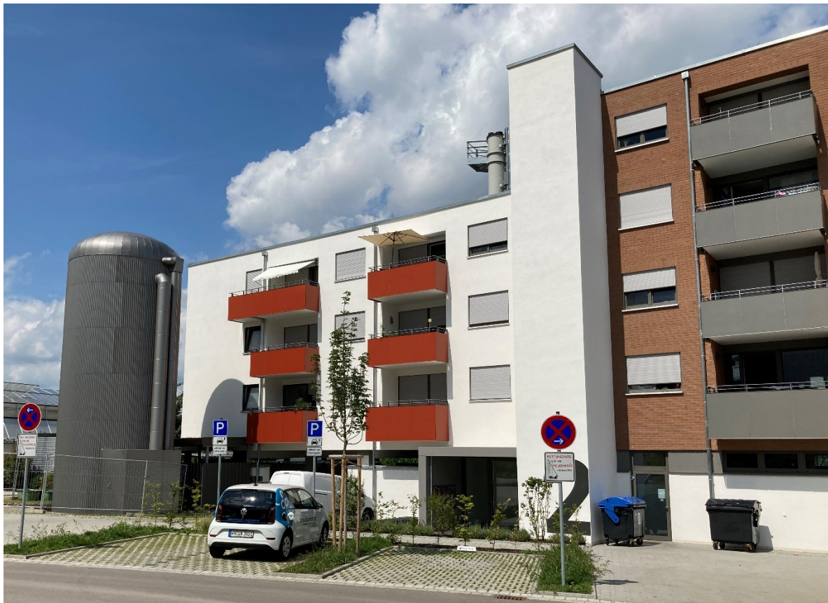
Gebäude mit Wohnhaus und neuer Energiezentrale EZ3 im UG, im Junkeräcker, zur Wärmeversorgung der Gebiete Halde V und Endersbach West
