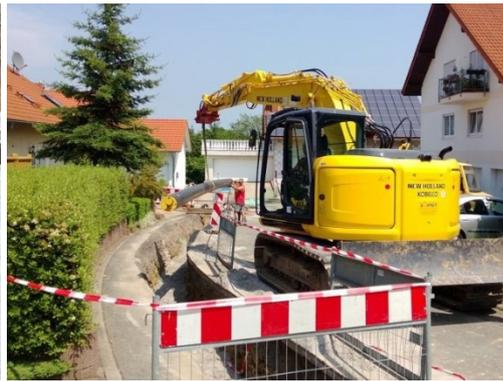
Abb. 48: Verlegung KMR-Rohr
