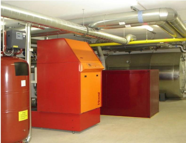
Abb. 2: Blockheizkraftwerk und Heizkessel
