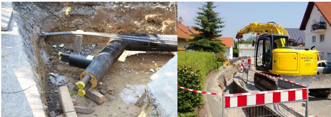
Abb. 47: links: KMR-Duo-Rohr, rechts: Verlegung KMR-Rohr
