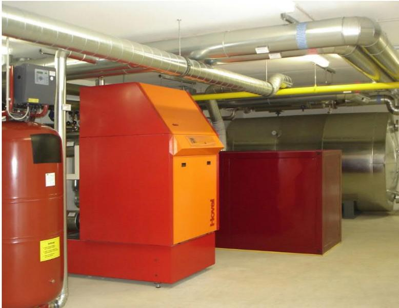
Abb. 2: Blockheizkraftwerk und Heizkessel
