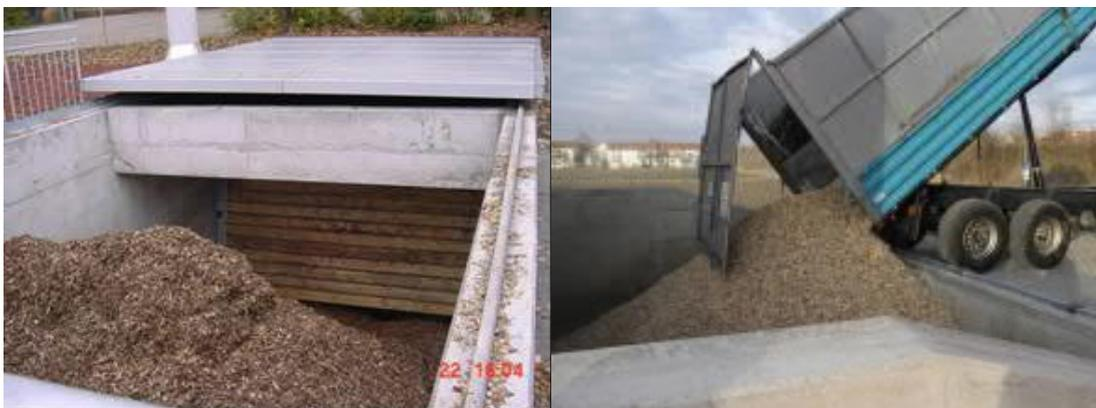
Abb. 9: links: Silo bei geöffnetem Deckel, rechts: Anlieferung Holzchnitzel
