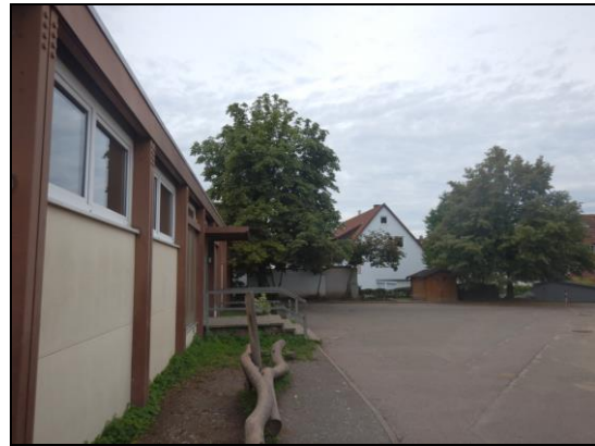
Südlicher Schulhofbereich (Abbruchgebäude 1) mit entfallendem Baumbestand (Kastanie, Winter-Linde)
