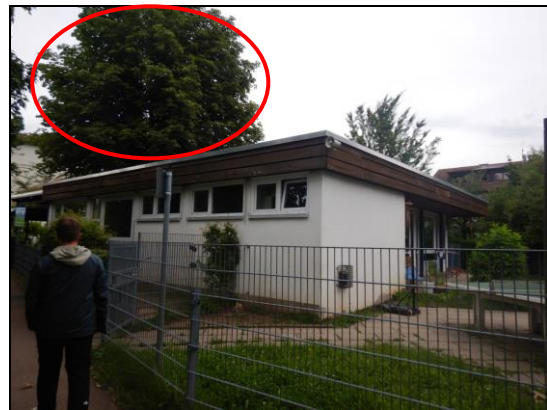
Zentrales Gebäude (Abbruchgebäude 2) mit umgebenden Spielmöglichkeiten (Kastanie mit Baumhöhlen im Hintergrund)
