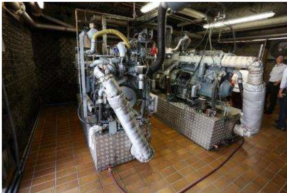
Blockheizkraftwerke
