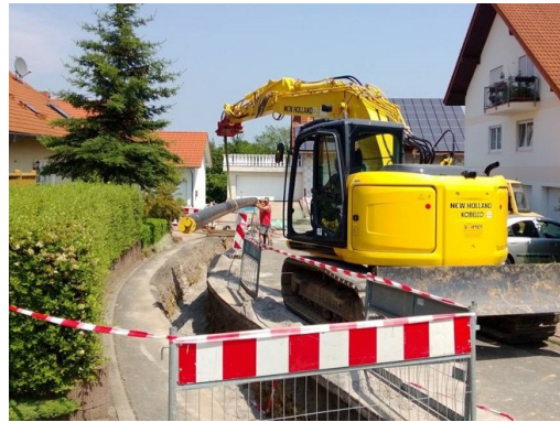
Abb. 19: Verlegung KMR-Rohr
