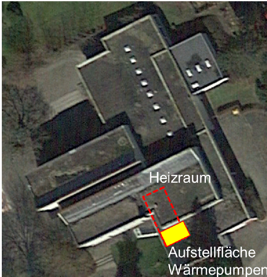
Abb. 17: Aufstellfläche Wärmepumpen auf dem Dach der Grundschule (Quelle: Google Earth)
