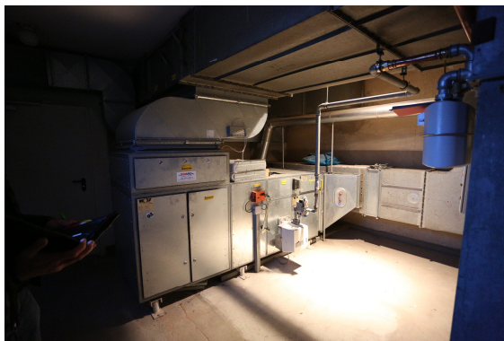
Abb. 7: direktbefeuerte Lüftungsanlage
