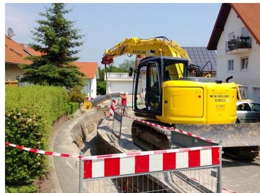
**Abb. 24:** Verlegung KMR-Rohr
