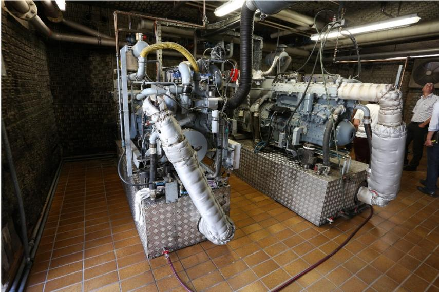
**Abb. 5:** Klärgas-Blockheizkraftwerke
