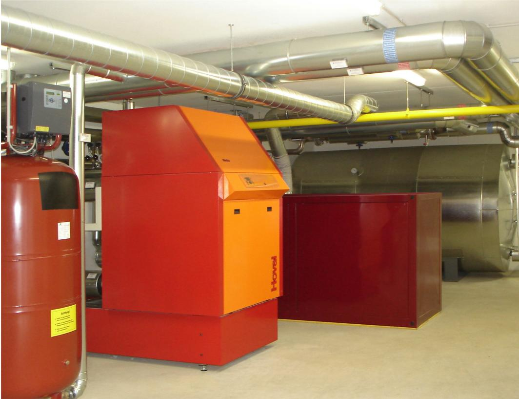
**Abb. 28:** Blockheizkraftwerk und Heizkessel
