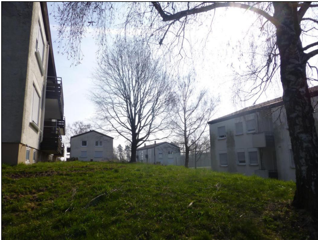
Abbildung 1: Zentraler Bereich mit Wohnbebauung
