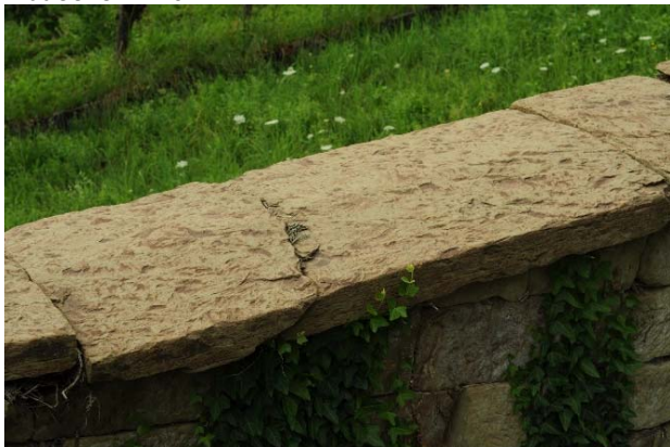
Abb. 16 Bruch des Abdeckers Treibende Pflanzen drücken Stein nach oben Beurteilung: Erhalt möglich, Kleben des Bruchs
