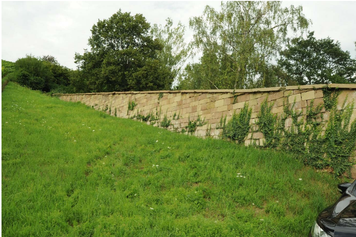
Abb. 02 Friedhof Strümpfelbach, Außenansicht der Mauer von Westen 2019
