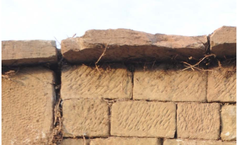
Abdecker S01 Außenansicht
