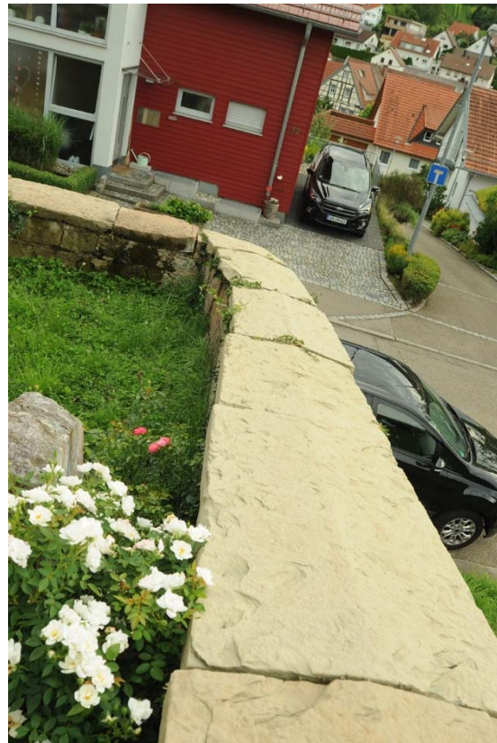
Abb. 05 Verlauf der Mauer innenseitig an gleicher Stelle
