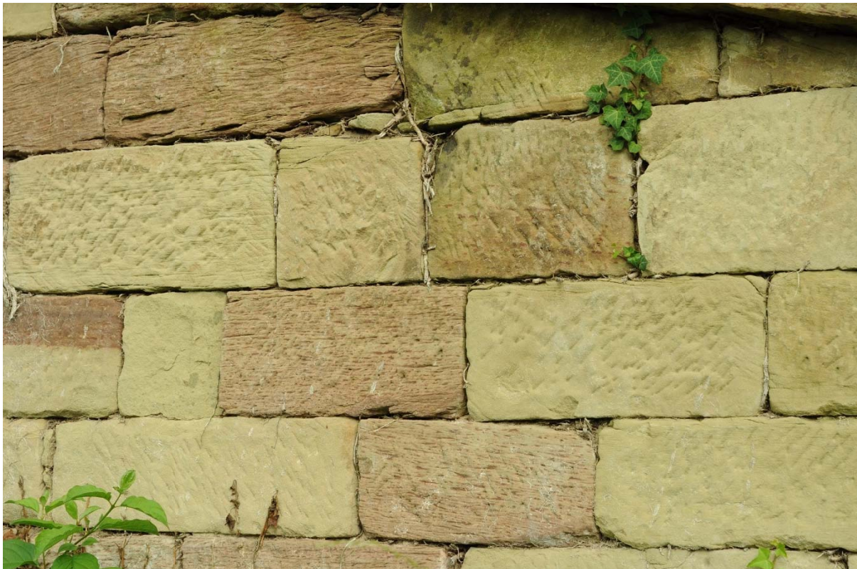
Abb. 03 Außenansicht, Detail zu Steinvarietäten, Oberflächenbearbeitung und Mauerwerkstruktur
