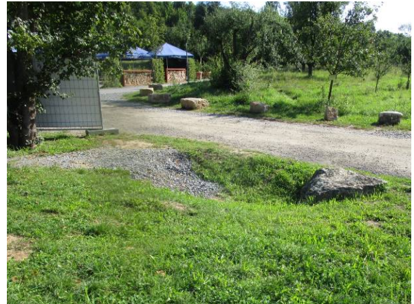
Abb. 16: Graben am Schotterweg im Osten
