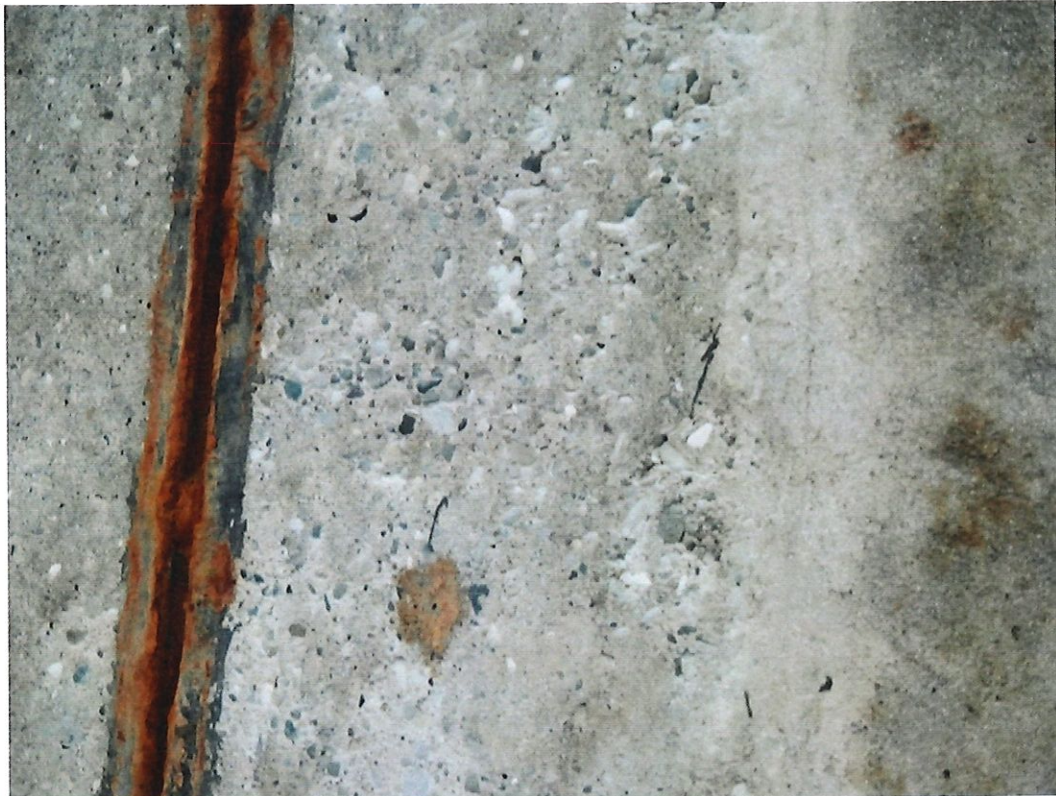
Abb. 8: Stark korrodierte Halfenschiene
