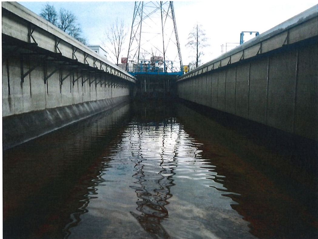
Abb. 1: Ansicht von Ost nach West
