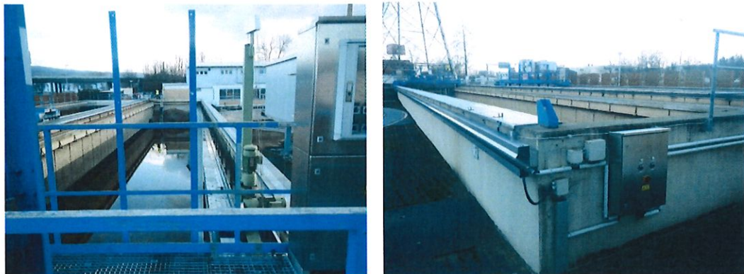
Abb. 2 und 3: Ansicht von West nach Ost und Südostseite
