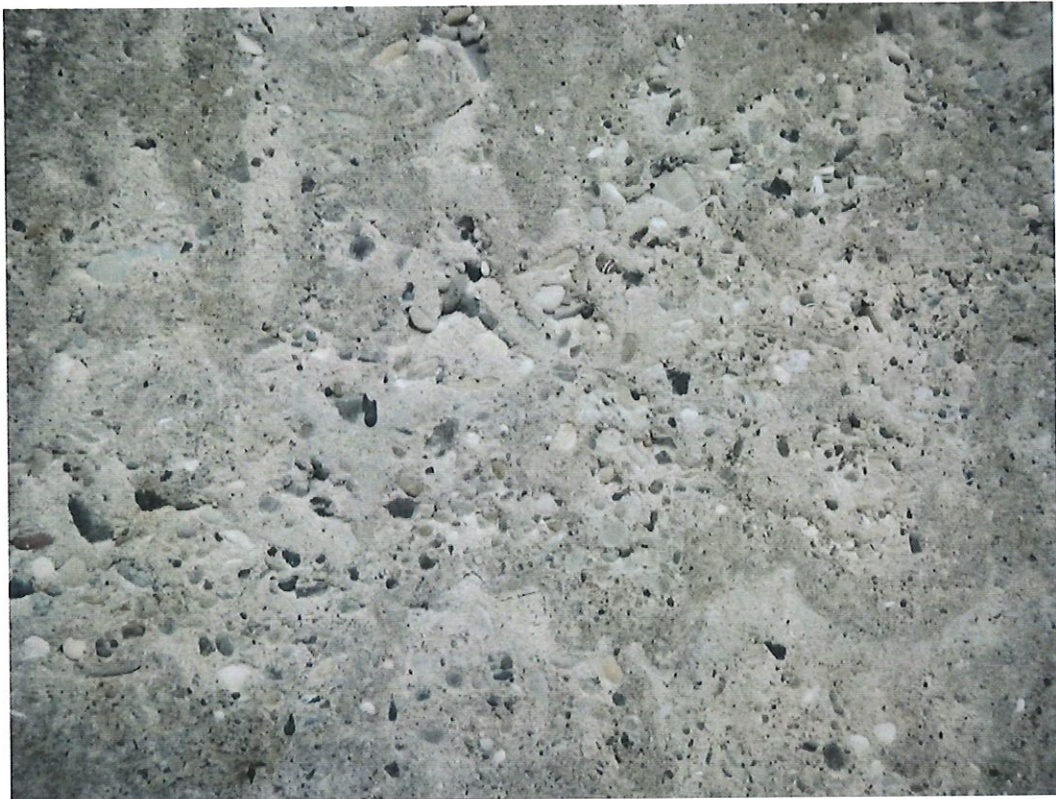
Abb. 4: Wandfläche mit Waschbetonartiger Oberflächenstruktur
