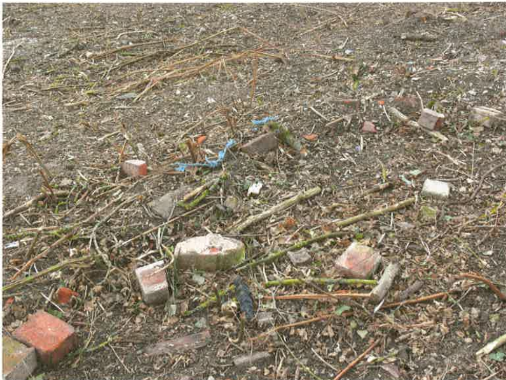
Bild 10: Bauschutt an der Oberfläche Birkelspitze (Aufnahme 08.03.2017)
