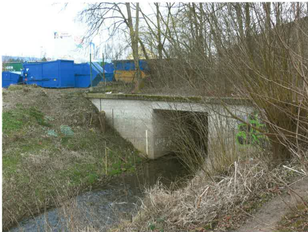
Bild 4: Auslauf bestehende Verdolung (Aufnahme 08.03.2017)
