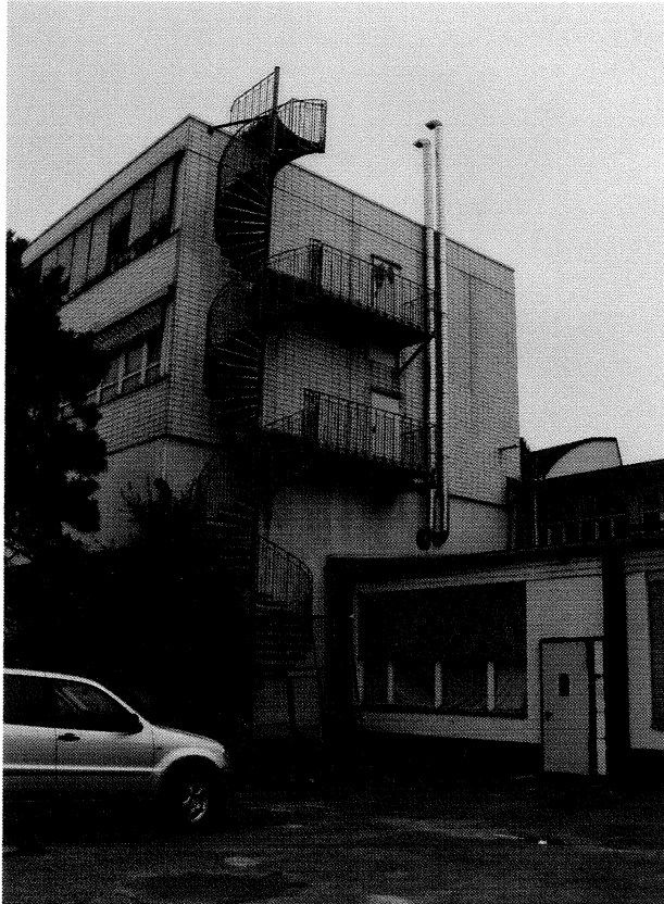
Bild 4: Gebäudekomplex Birkelstraße 21 Westteil - Südseite
