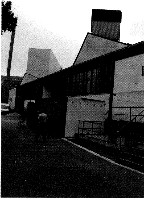
Bild 6: Gebäudekomplex Birkelstraße 21 - Nordseite
