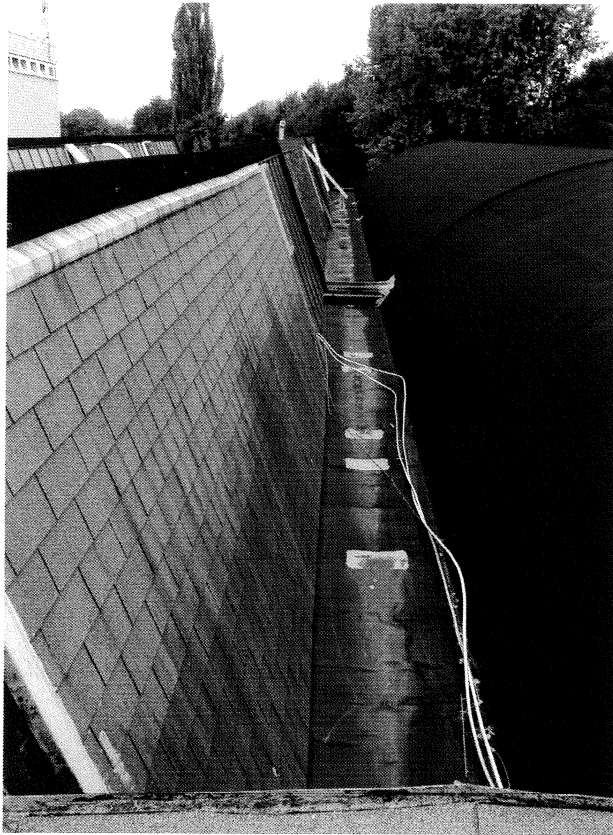
Bild 8: Gebäudekomplex Birkelstraße 21 Sheddach Nordwestteil
