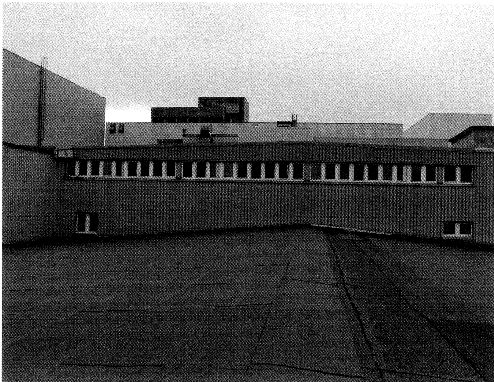
Bild 7: Gebäudekomplex Birkelstraße 21 Dachfläche Blickrichtung Osten
