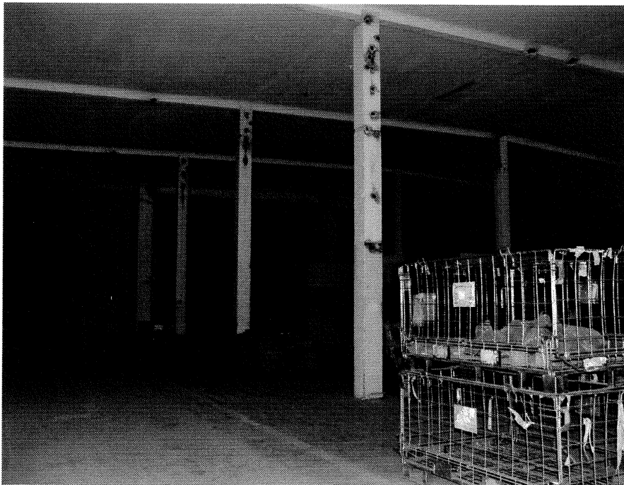
Bild 9: Gebäudekomplex Birkelstraße 21 Stahlstützen mit Verputz - OG
