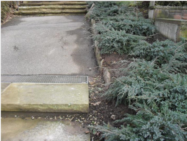
Stufen und Einfassungen
