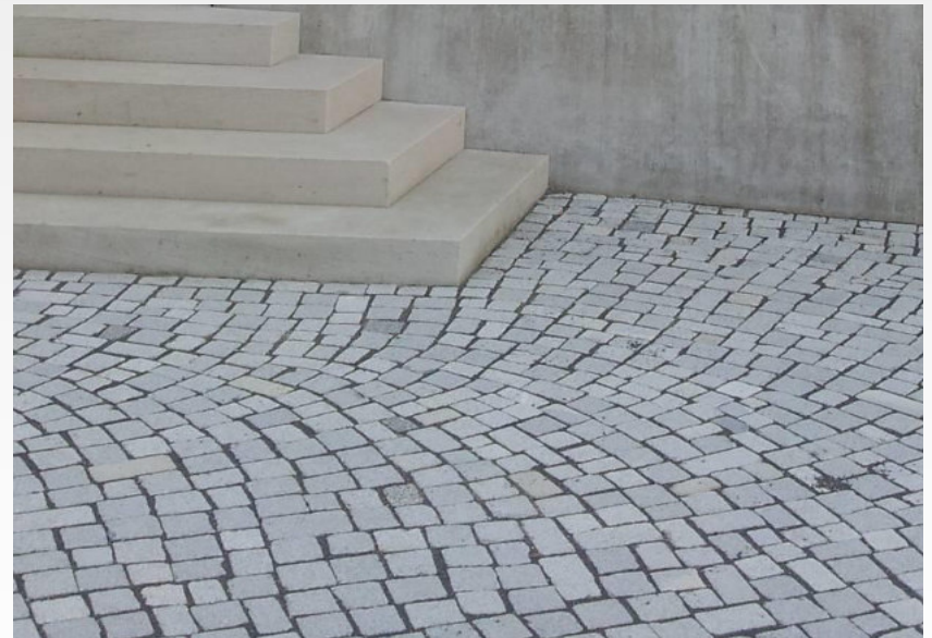
Naturstein Passe-Verband, Sandsteinstufen
