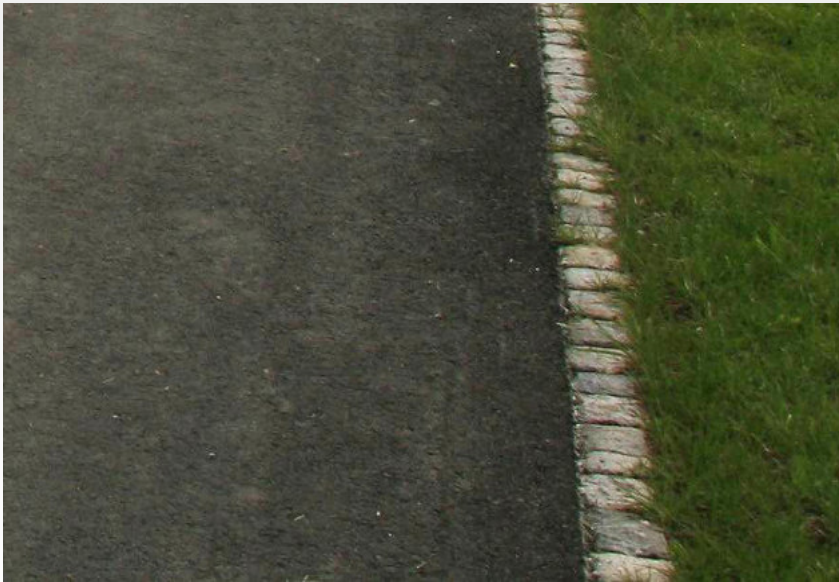
Asphaltweg mit Pflaster-Einfassung
