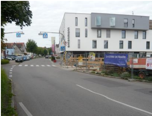
Strümpfelbacher Straße 20 (Richtung Westen)
