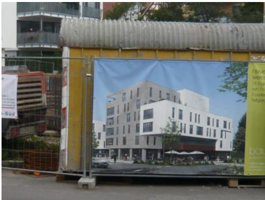
Bauvorhaben Strümpfelbacher Straße
