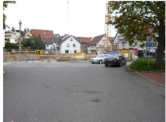
Kreuzung Pflaster/Strümpfelbacher Straße
